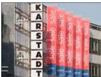
Aus den Karstadt Häusern könnten Shopping Malls werden
